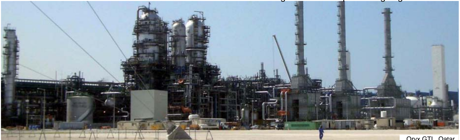
Oryx GTL, Qatar
