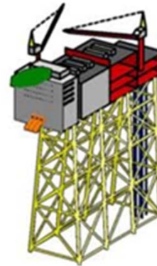
Hejre Platform Denmark
